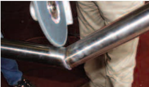
Tratamiento del ángulo interior con una herramienta de acabado de ángulo interno.
